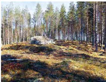
Avverkning. Innan grävarbetena påbörjas har skogen avverkats.
